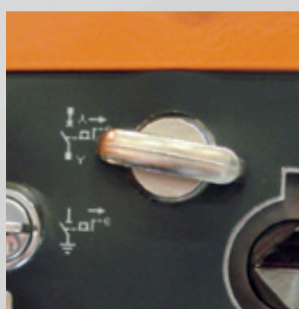
Circuit breaker anti-racking-in lock Blocco inserimento interruttore Verrouillage d'insertion disjoncteur
